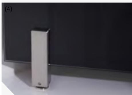
(4) La seconde partie de la charnière est encastrée dans le sol et fixée sur un pivot. Une solution très élégante.
