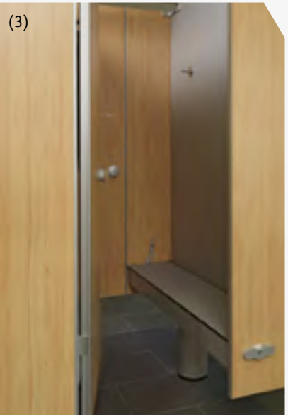
(3) Pied central sous la banquette de cabine. Cette solution permet de construire la cabine sans socles. Pour cela, une structure métallique est vissée sur le sous-plancher en béton avant même la pose de la chape, afin de garantir une très grande stabilité. La condamnation des deux portes de cabine est réalisée simultanément à l'aide de la planche inférieure de la banquette centrale. Le témoin « libre-occupé » de grande dimension, bien visible et comportant un dispositif d'ouverture de secours, en facilite l'usage.
